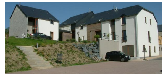
Exemple de logements tremplin à Martelange
