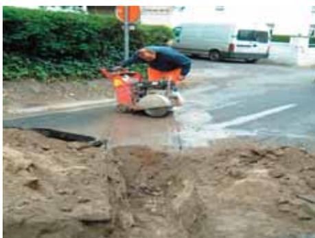
Rue du Carmel, une canalisation d'égout obstruée nous a contraints à ouvrir la voirie afin de remplacer une partie de la conduite.
