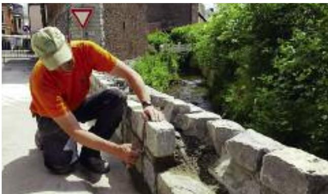
Rue du Cul du Ry, les maçons ont terminé la réfection du mur de la berge du « Wéry ». Ces travaux consistant en la pose d'un voile de béton pour soutenir la berge, en la reconstruction du mur en pierres, et d'un couvre-mur coulé sur place.
