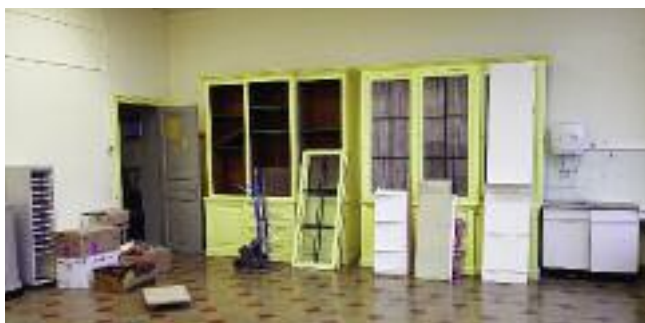
À l'école de Franière, l'heure est au déménagement avant une rénovation des plafonds, murs et sols, des classes de l'étage. Certains travaux seront réalisés par le Service Travaux.
