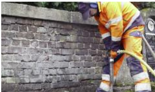
Au cimetière de Franière, la démolition des caveaux abandonnés continue. Certains ne seront démolis que partiellement avant d'être restaurés par nos maçons et revendus avec l'emplacement. Renseignements auprès du Service Travaux.
