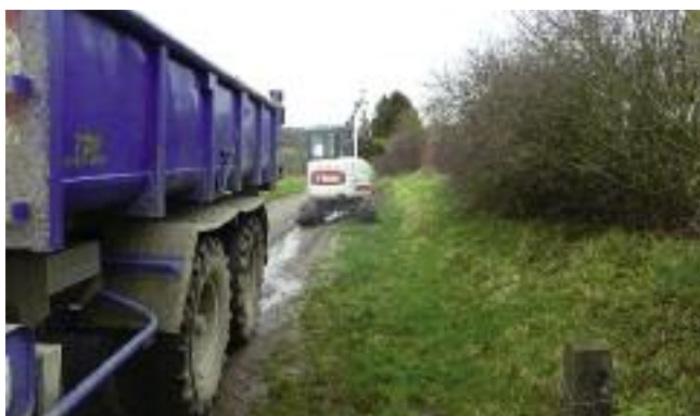
En cette période hivernale, notre Service Voirie remet en état des chemins agricoles. Ils rebouchent des trous, curent les fossés ou s'attèlent au reprofilage complet (photo chemin des Deux Pays).
