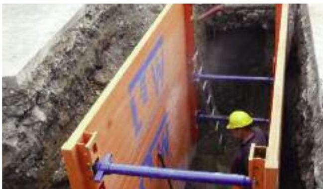
Au Chemin privé, réalisation d'un nouvel égouttage à une profondeur importante.
