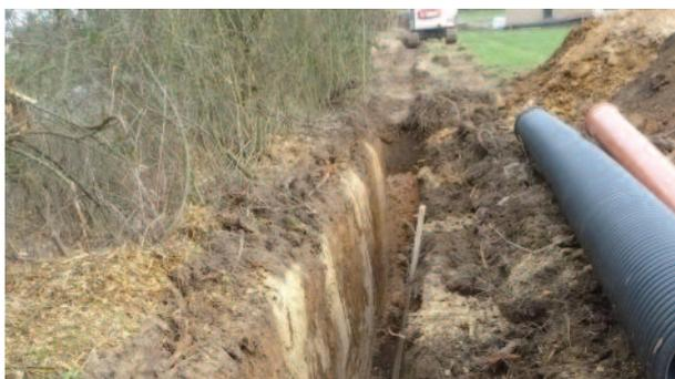
Rue de Malonne (Buzet), nous réalisons une extension-extension de l'égouttage avec pose d'une double canalisation pour eaux pluviales et eaux usées.
