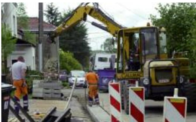
A la rue des Nobles à Soye, une nouvelle pose de filets d'eau et avaloirs a été réalisée afin d'apporter solution à un problème d'eau stagnante.
