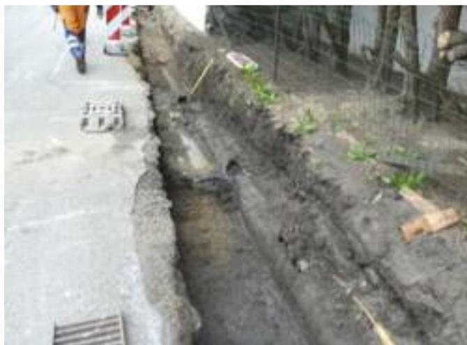
En début de chantier, l'une de nos équipes de voirie réalise plusieurs sondages afin de localiser les câbles et installations d'impétrants ainsi qu'un ancien tunnel du charbonnage passant sous la voirie. Le but des travaux est de remplacer une canalisation devenue trop petite.
