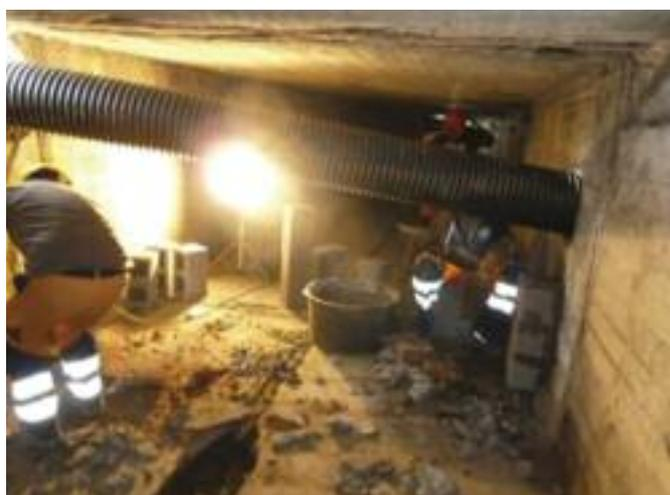
Le tunnel a dû être percé de part en part. Notre maçon, Stéphane, accompagné de Jacques et Gaby, réalise ici des colonnes pour soutenir la canalisation.
