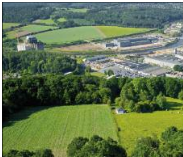
Vue sur les installations de ALIA2 et du BEP Environnement © BEP
