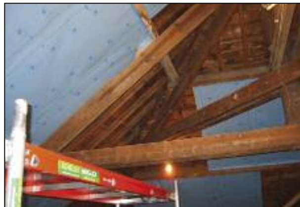
Toiture de la bibliothèque de Franière – travaux d'isolation – pose de 20 cm d'ouate de cellulose par insufflation.
